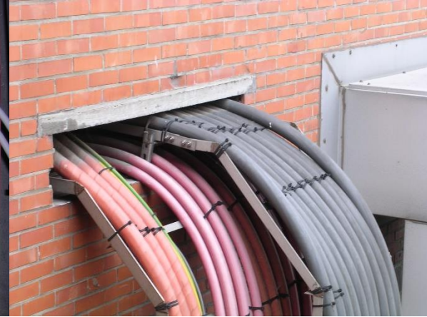
Kabelbanen / kabelgoten
