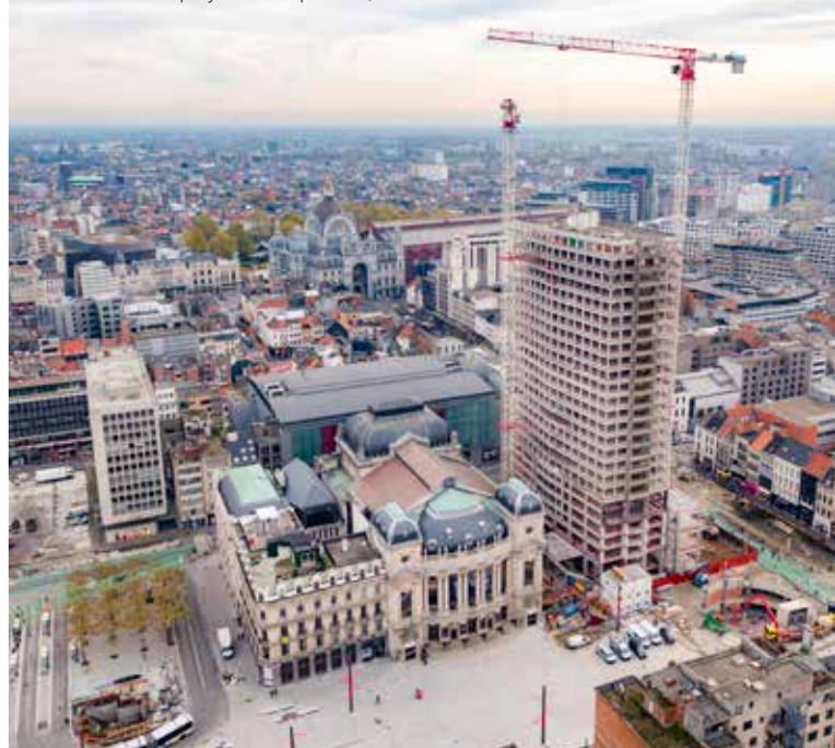
Photo aérienne : projet Antwerp Tower, à Anvers
