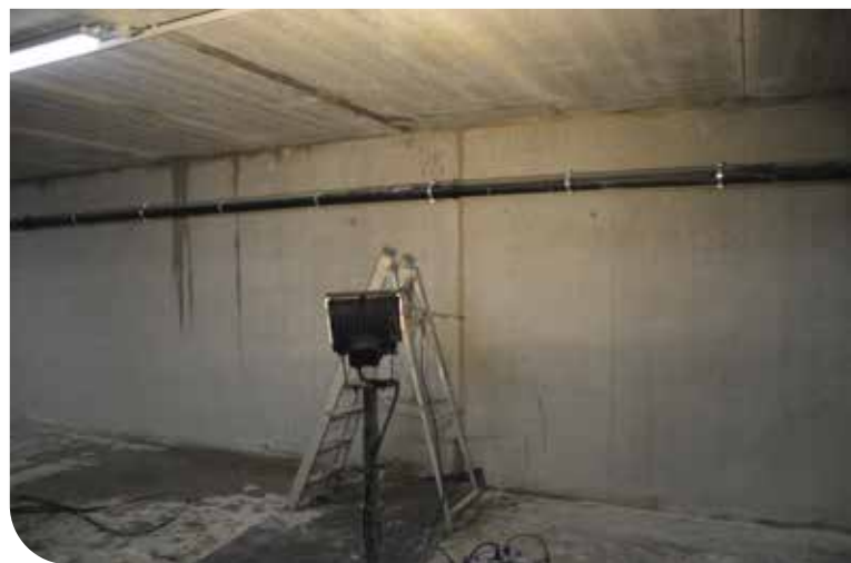
La différence entre un mur traité par injection (à droite) et un mur pas encore traité (à gauche)
