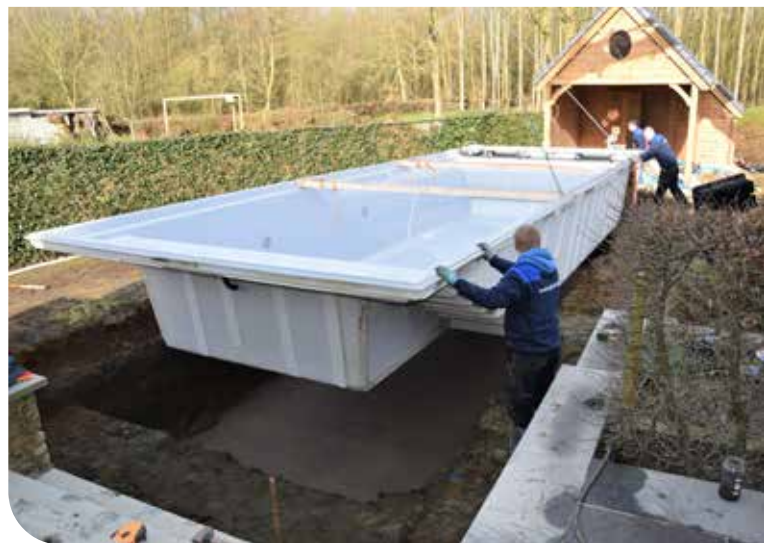
Livraison d'une piscine à coque
