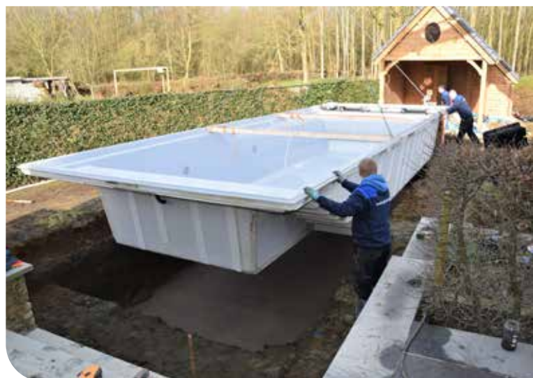
Livraison d'une piscine à coque
